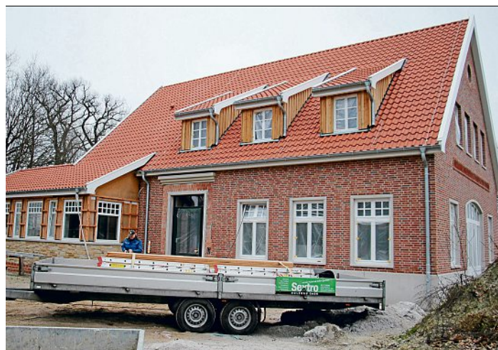
Ort der Begegnung: Sofern die Bauarbeiten nach Plan laufen, soll das Haus im Sommer in Betrieb genommen werden.
