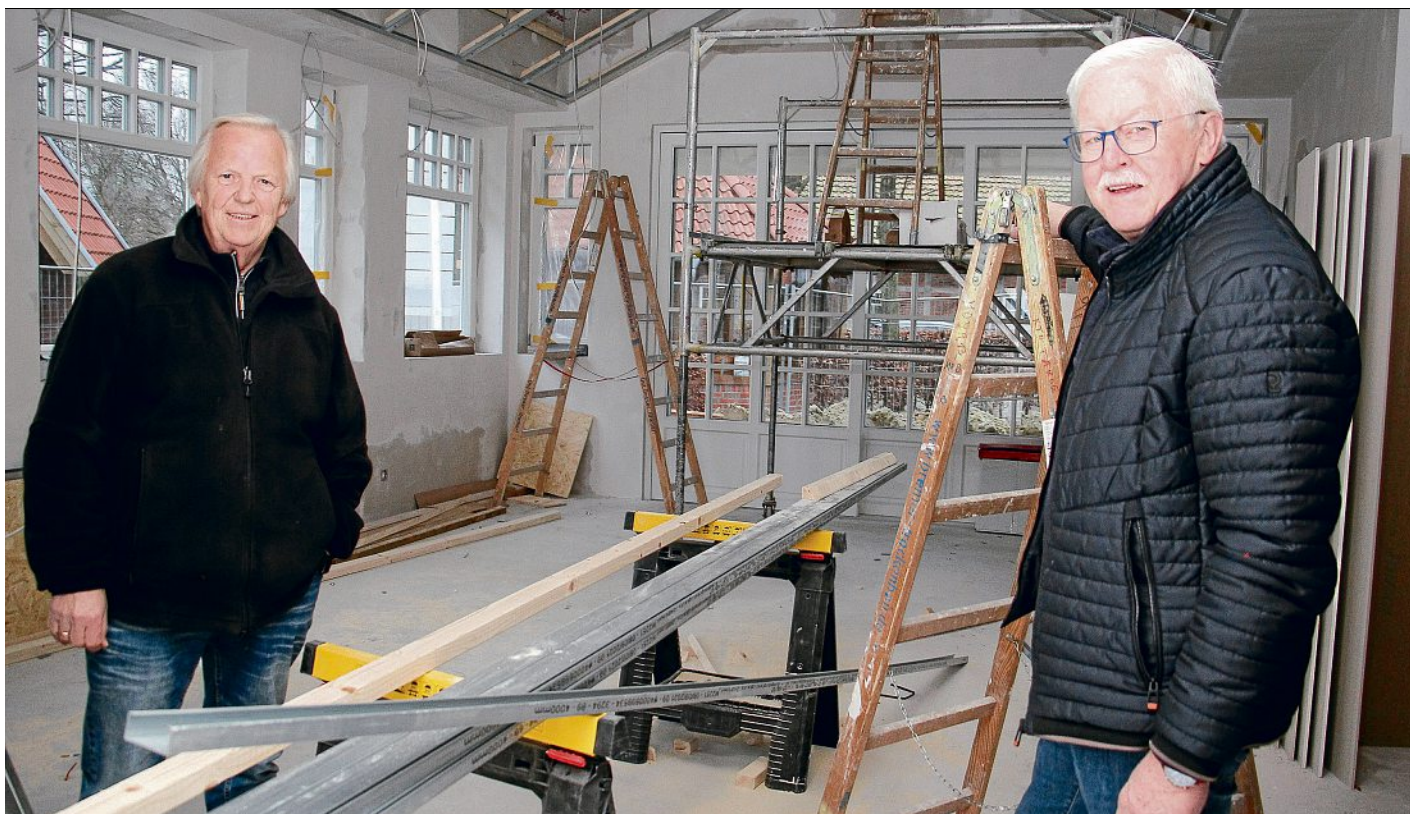
Der Innenausbau macht Fortschritte: Der Vorsitzende der Dorfgemeinschaft Spreda-Deindrup, Reinhold Bothe (rechts), und sein Vorgänger Hartmut Kurzbach, zugleich Vorsitzender des Arbeitskreises Dorferneuerung, werfen einen Blick in das künftige Café des Inklusionshauses. Fotos: Speckmann
