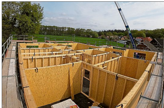
Die Holzrahmenbauaufstockung.
