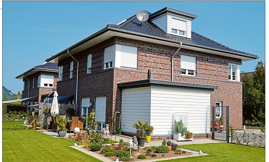
Aus dem Hause Sextro Holzbau: Erstellung von 4 Wohneinheiten in Holzrahmenbauweise.
